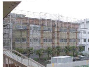
・外壁の足場
